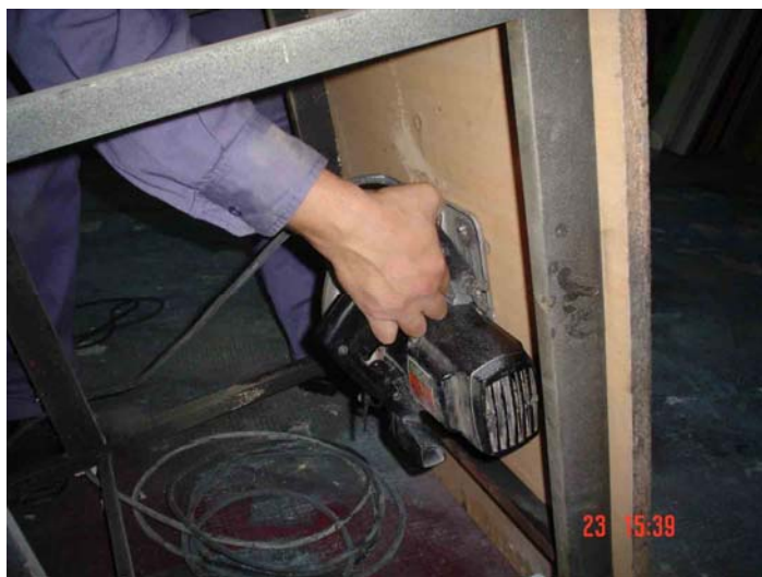
Foto 24: colocación por parte del operario de la sierra eléctrica.
